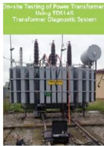
Diagnostica completa del trasformatore di alimentazione sul luogo d'installazione mediante diagnostica dinamica della resistenza del commutatore sotto carico, misurazione della trasmissione e resistenza dell'avvolgimento.
