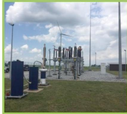
Diagnostica completa dei cavi: dalla verifica sul luogo di installazione dei cavi di alimentazione di media e alta tensione si possono valutare le condizioni del cavo, in modo da garantire il funzionamento completo ed affidabile dei parchi eolici.
